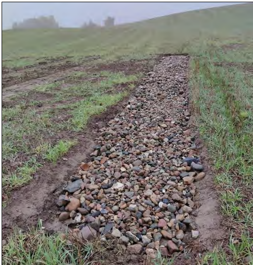
Figur 23: Eksempel på en nyanlagt overløbskarm fra et lignende lavbundsprojekt.
