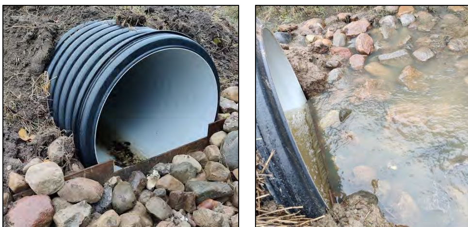
Figur 22: Eksempel på afløb fra andet projekt. Tv: nyanlagt inden vandføring. Th: afløb i funktion.
